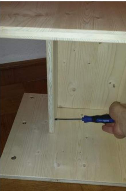
Als nächstes klippen wir die Grundplatten für die Scharniere (C) in die Rückwand (T1) ein, so wie auf dem Bild zu sehen.
