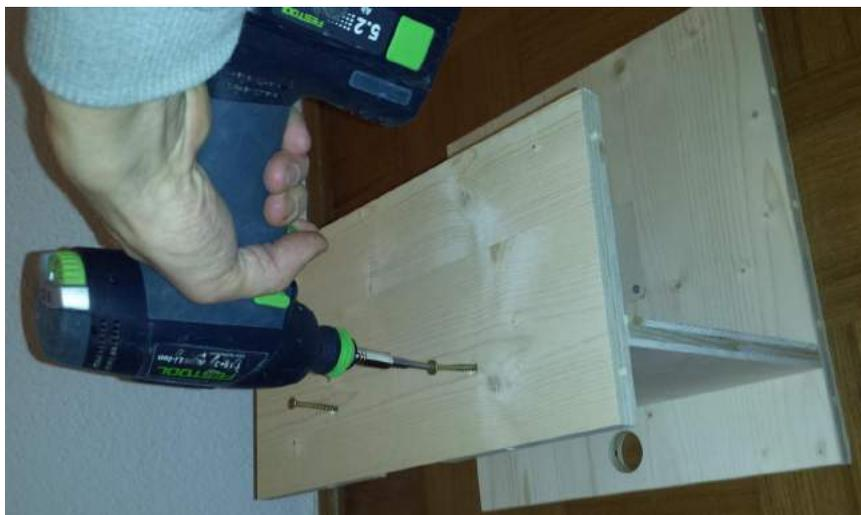
Nun wird das eben erstellte H mit den Seiten (T4 & T5) verbunden. Dazu schrauben wir zuerst je fünf Stück Mini Fix Bolzen (M) in die 5 mm Löcher in den Seiten (T4 & T5). Dann schlagen wir in die Rückwand (T1) auf beiden Seiten je zwei Dübel (L) ein. Achtung! Die Dübel nicht in die Löcher, die für die Mini Fix Bolzen (M) vorgesehen sind, einschlagen. Dann stecken wir die Teile wie auf den Bildern gezeigt zusammen.
